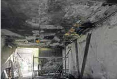
*Der Blick aus einer Halle unserer Liegenschaft „Flohrrhof“: Das Dach wurde zerstört, durchgeweicht und war einsturzfähig. Mittlerweile wurden alle Schäden behoben und das Dach komplett erneuert.*
