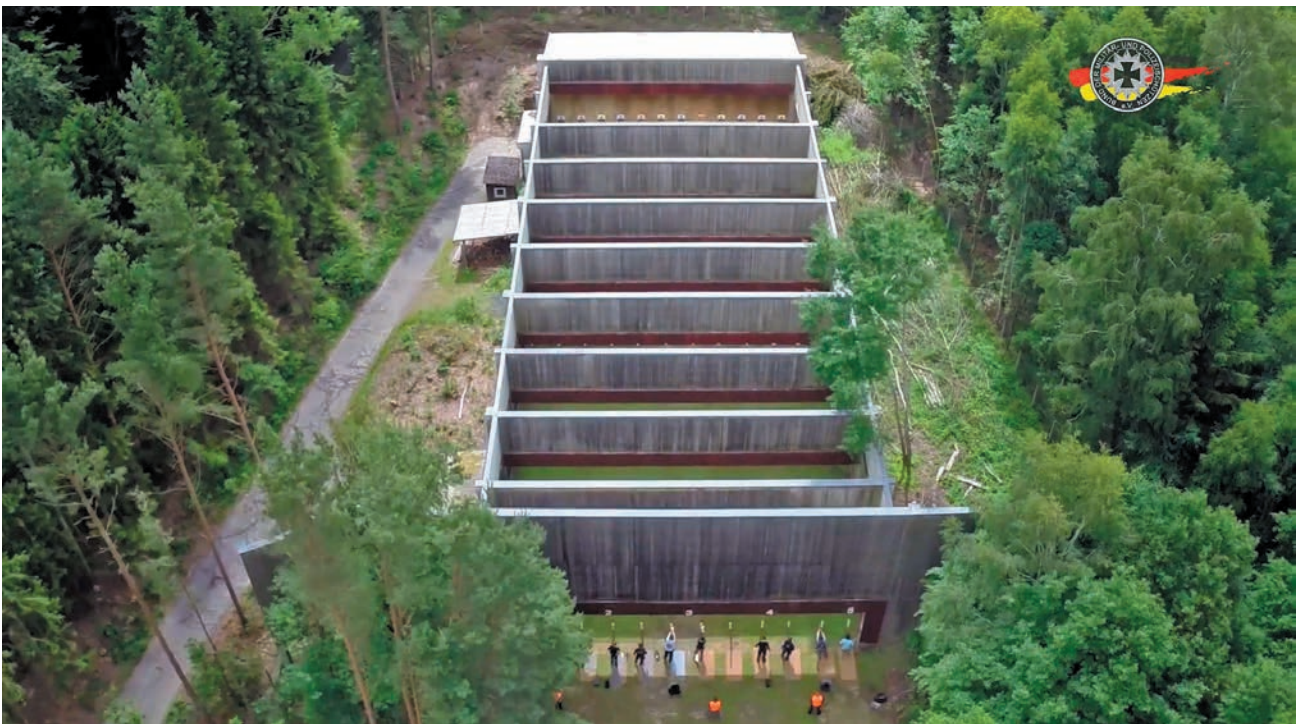
Luftaufnahme einer Drohne von der Anlage in Alsfeld.
